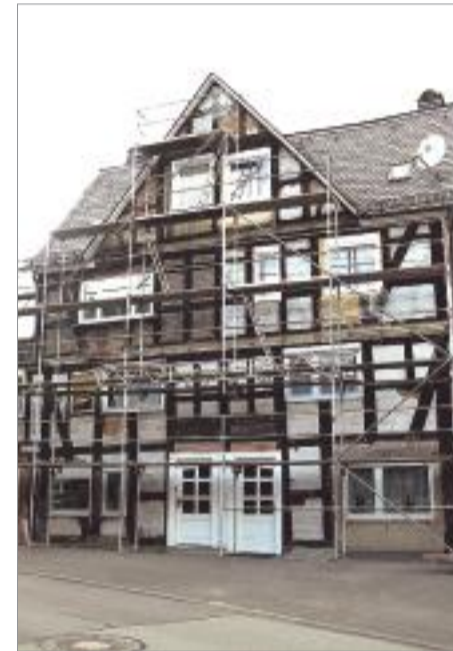
Während der Sanierungsphase entstand dieses Bild des Wohnhauses. Deutlich zu sehen die Trennung der beiden Haushälften. Foto: friwe
